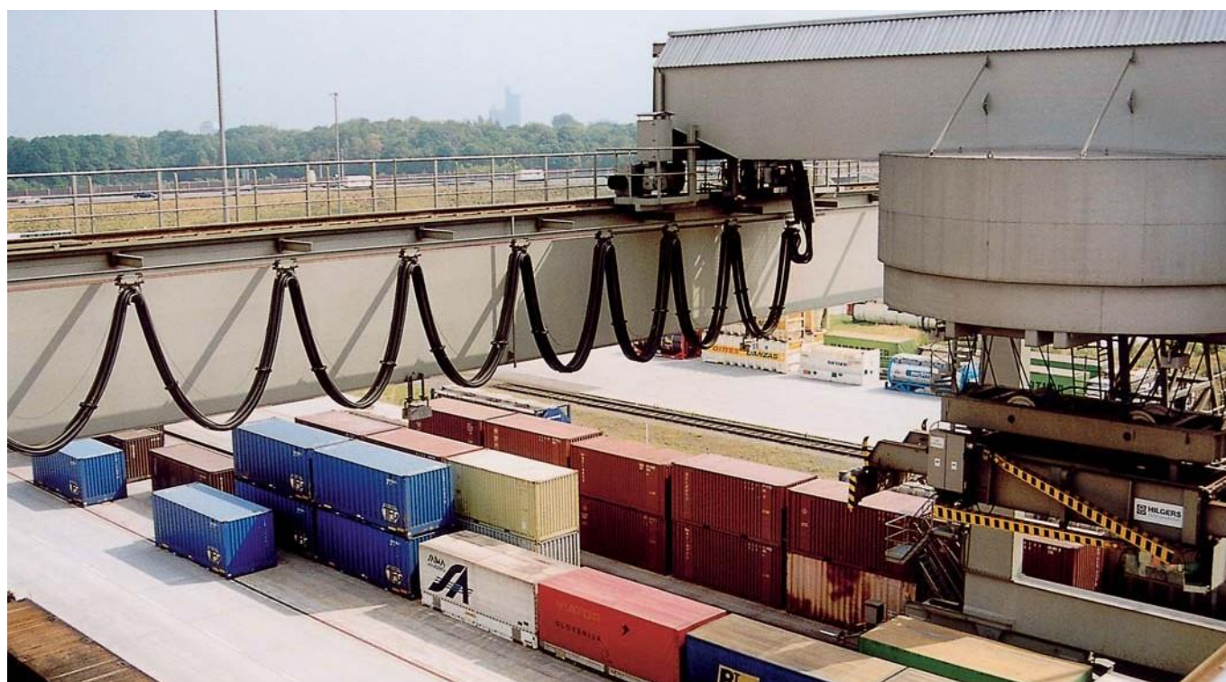
• Устройство кабельной тележки на контейнерном кране
