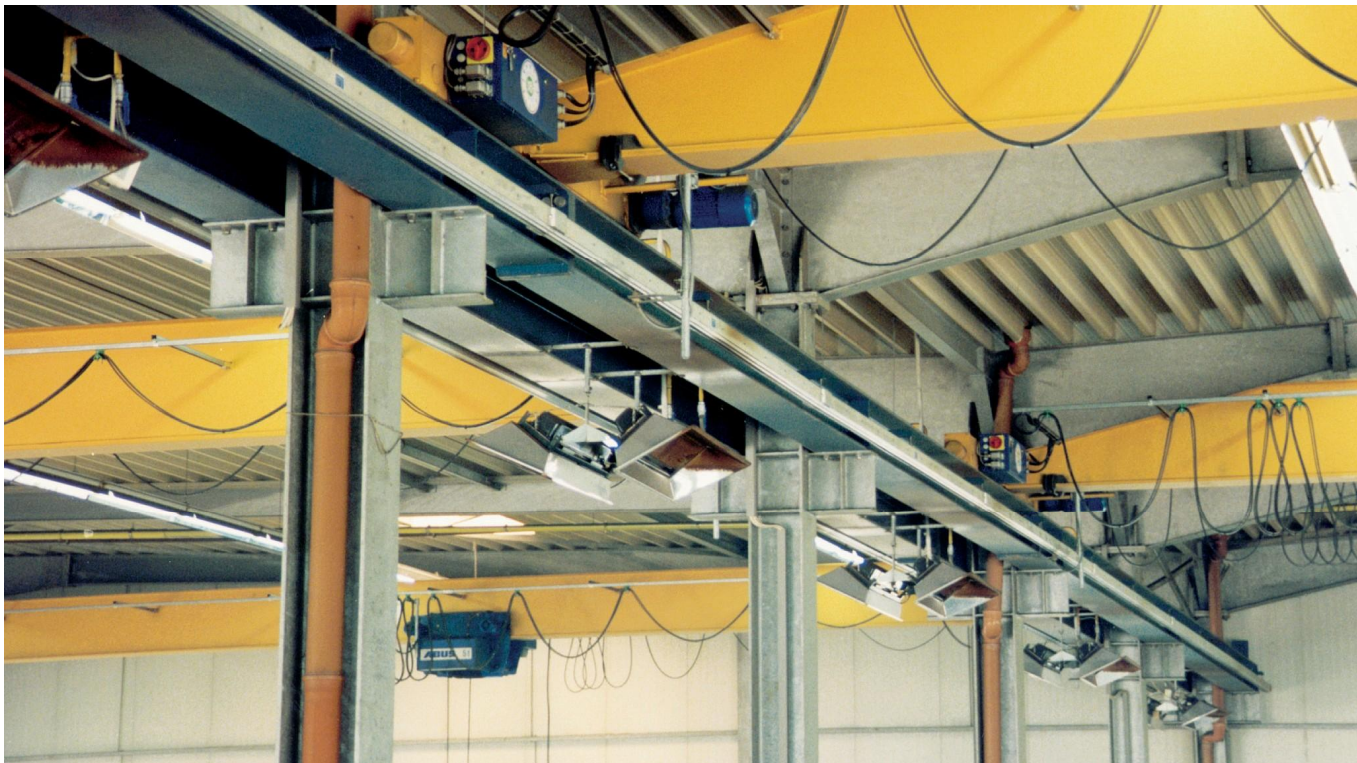
● Безопасный троллейный шинопровод LSV для цехового крана.
